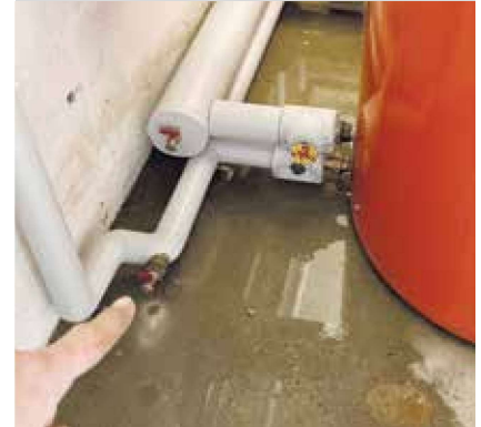
➔ Korrosionsschäden
